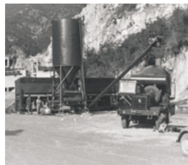
Impianto "Faenza" a 4 scomparti Faenza dry batching plant, 4 bins
