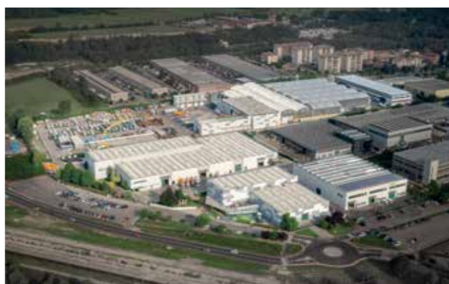
IMPIANTI DI PRODUZIONE
